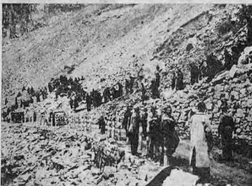
Brigada de prisioneros rojos trabajando en la retirada de escombros de la carretera en Pola de Gordon, León, que destruyeron volando penascos.
